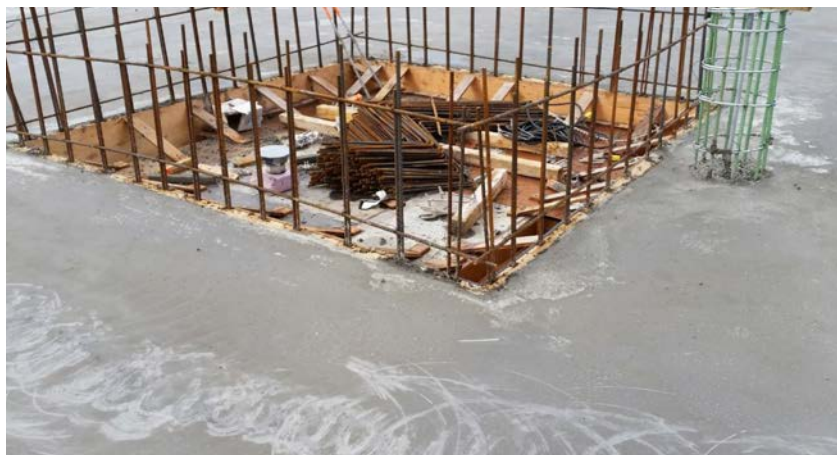
b) After pouring
