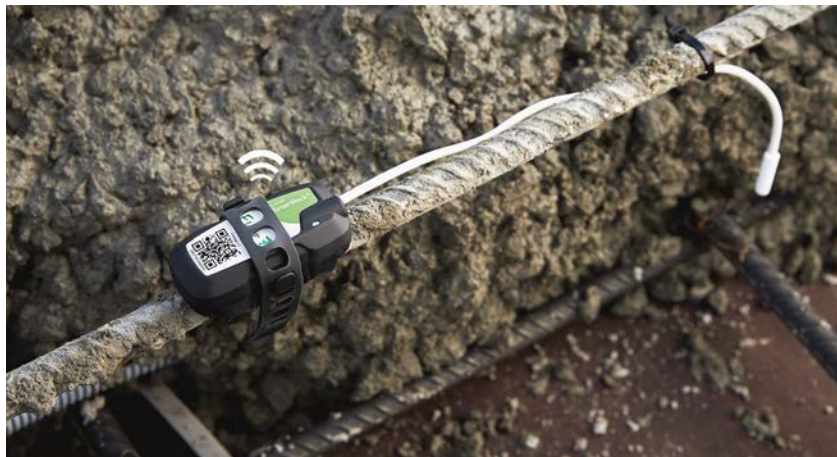
a) Before pouring
